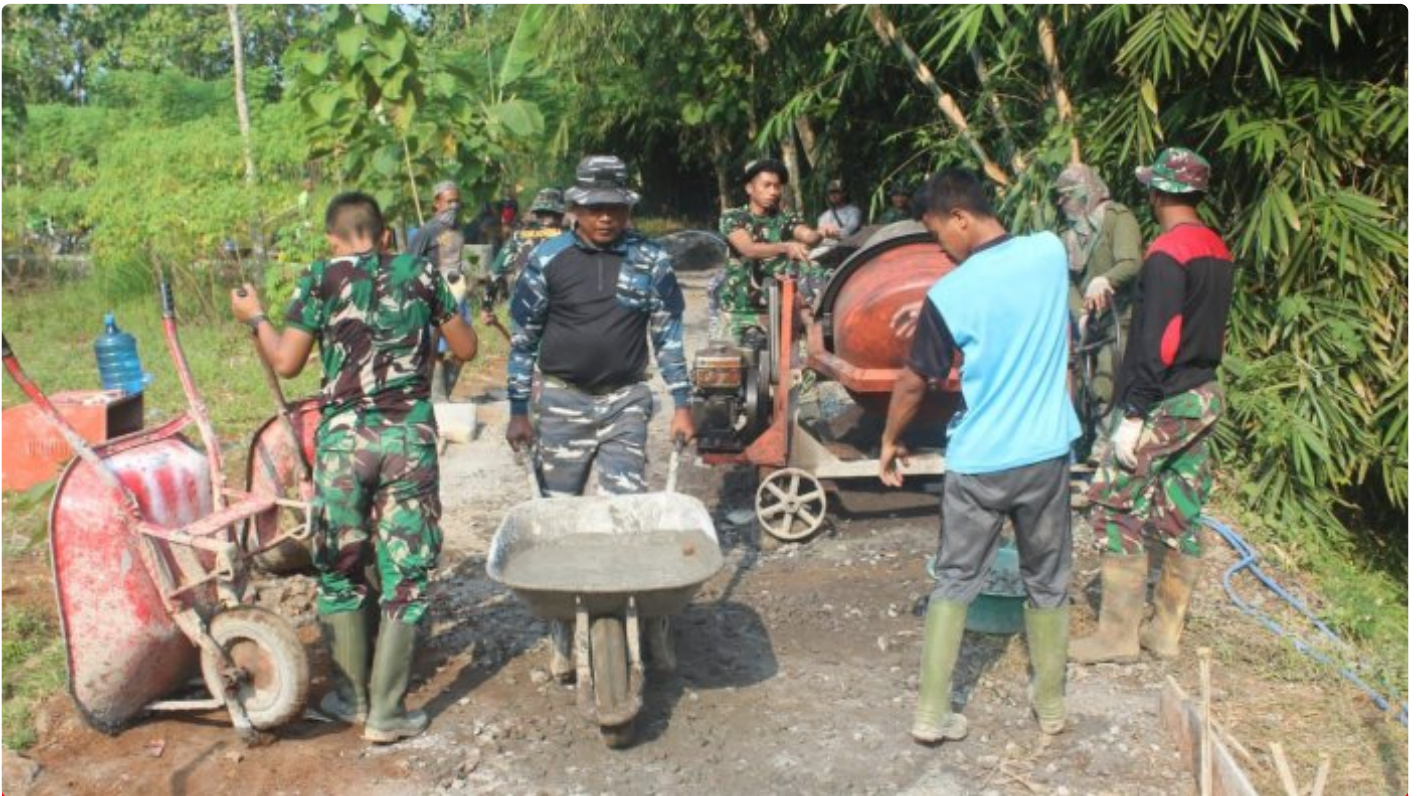
Satgas TMMD Reguler Kodim 0709/ Kebumen bekerja menyelesaikan semua sasaran fisik di Desa Pejengkolan
