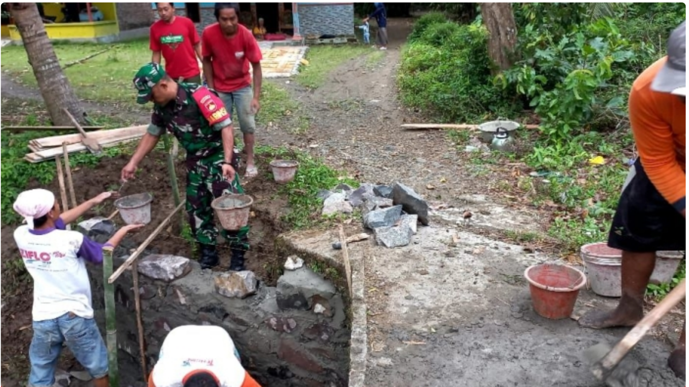
Tingkatkan Perekonomian, Babinsa Koramil 19/ Kuwarasan Karya Bakti Pembangunan Jembatan
